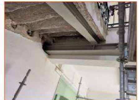
La nuova carpenteria strutturale
