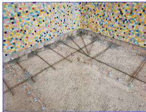
Connettori Technaria (TFS) nelle travi esistenti e barre ad aderenza migliorata (inghisato) nei muri portanti, lungo il perimetro dei diversi campi
