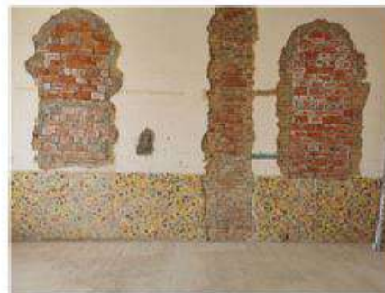
Ripristino della continuità muraria con mattoni pieni di laterizio
