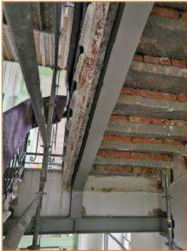
La nuova carpenteria strutturale
