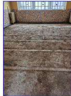
Struttura dei solai esistenti
