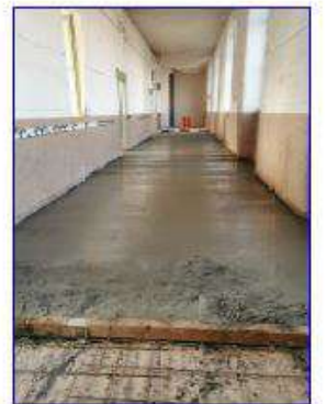
Getto strutturale, spessore 6 cm
