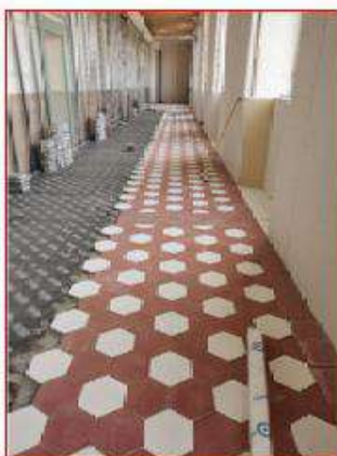
Pavimento corridoio in corso d'opera
