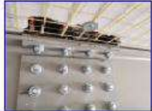
Bullonatura della carpenteria, posta all'intradosso dei solai - servizi igienici
