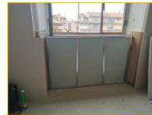
Sottofinestra coibentato
