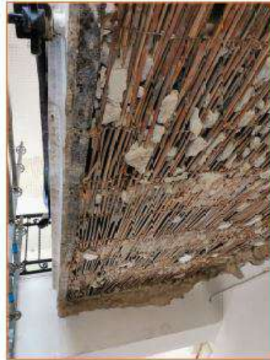
Controsoffitto preesistente con Incanniccio di palude
