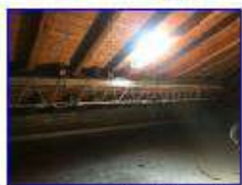
Intervento strutturale sulla trave lignea del sottotetto
