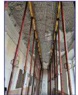
Puntellamento preliminare dei solai
