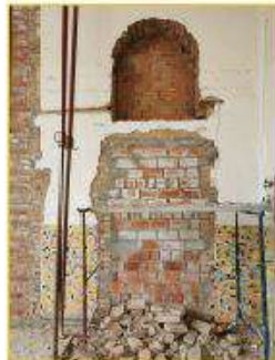
Ripristino della continuità muraria con mattoni pieni di laterizio
