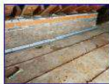
Intervento strutturale perimetro sottotetto
