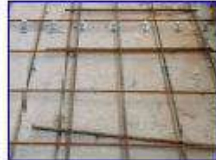
Connettori Technaria (TFS) nelle travi esistenti e barre ad aderenza migliorata (inghisato) nei muri portanti, lungo il perimetro dei diversi campi
