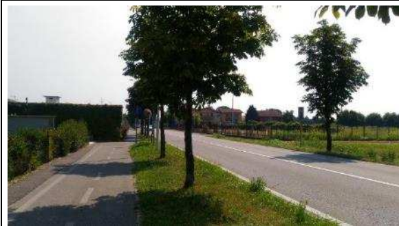
Foto 13: la SP 11 in direzione est
